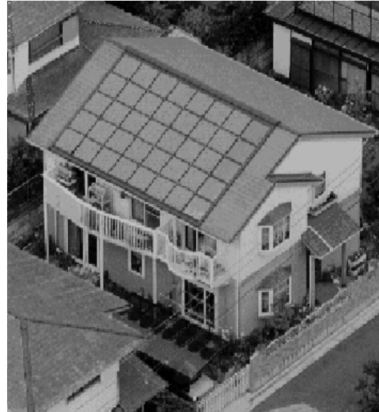
図4 建材一体型太陽電池を屋根に搭載した自宅の航空写真(産経新聞社提供)
