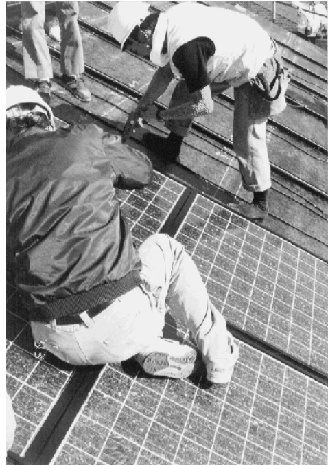
図2 太陽電池モジュールの上に乗ってのネジ止め作業
