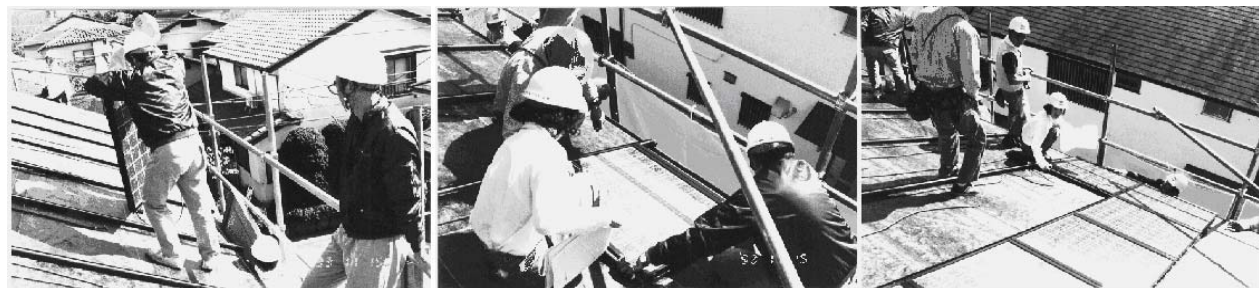
図2 太陽光発電パネル取付工事風景
