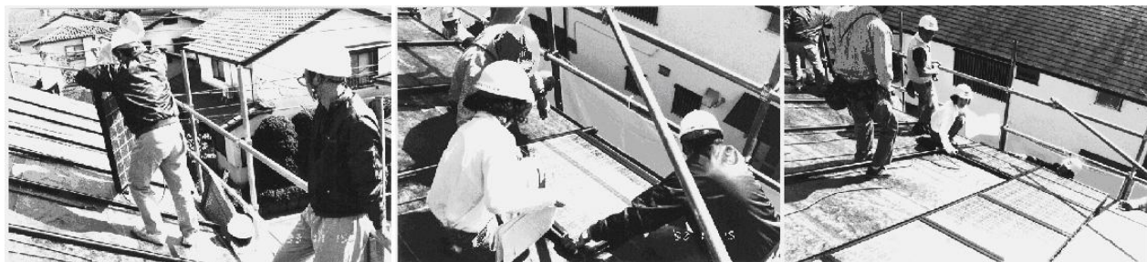
図 2 太陽光発電パネル取付工事風景
