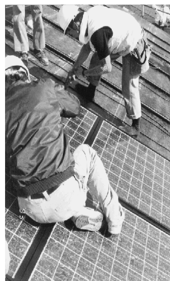
図 3 太陽光発電モジュールの上に乗ってのネジ止め作業
